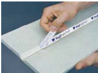
Abdeckfolie vom VogIFalt-Fix-Band entfernen.
